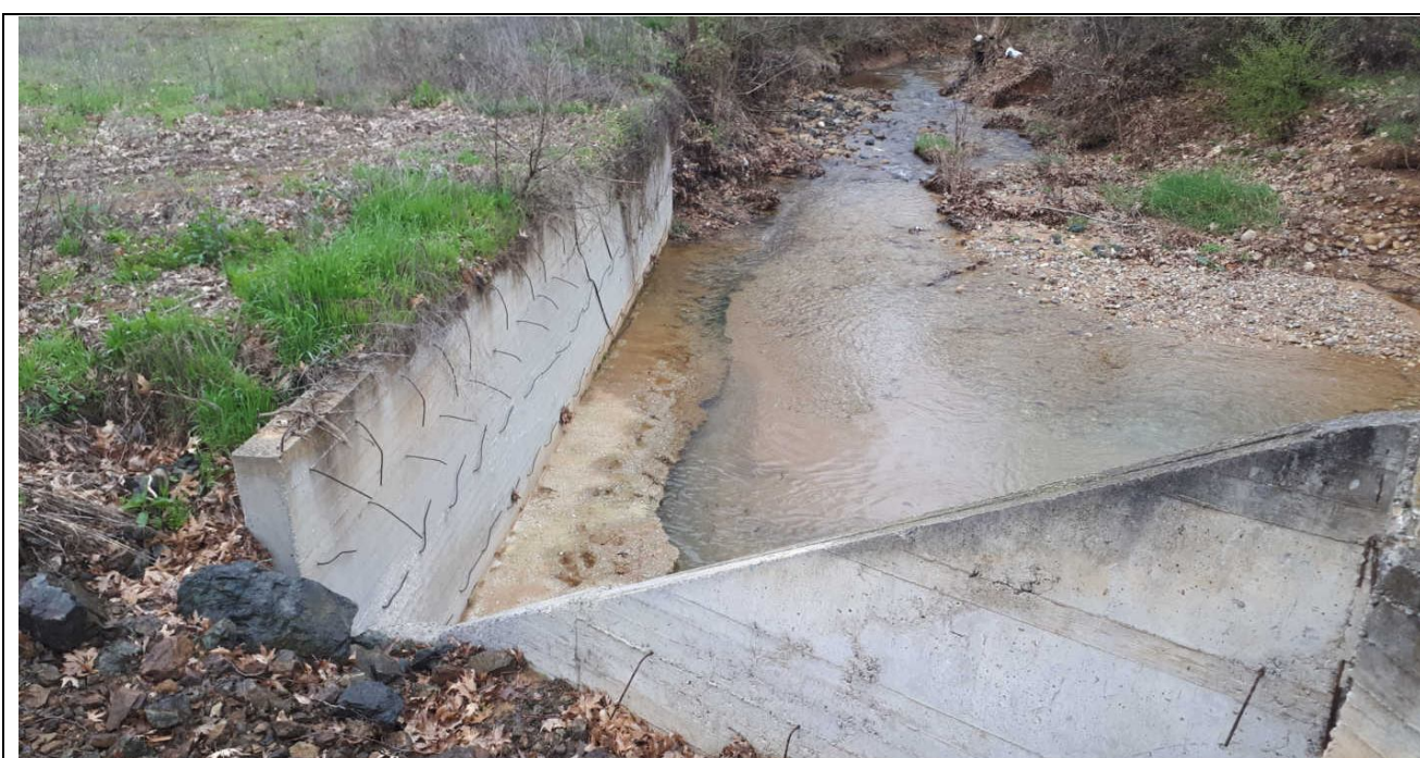
ΦΩΤΟΓΡΑΦΙΑ 3: Λήψη από την οδό. Διακρίνεται ο τοίχος αντιστήριξης της κοίτης στην επέκταση του τοιχείου αντιστήριξης.
