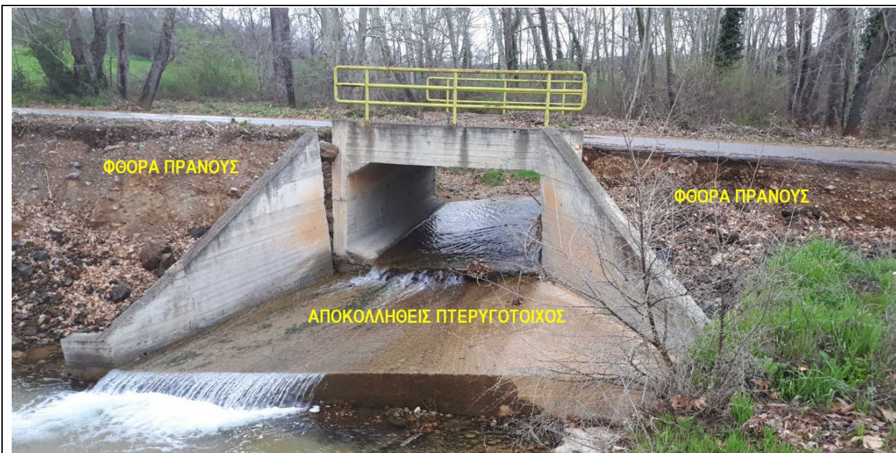
ΦΩΤΟΓΡΑΦΙΑ 2: Λήψη από τα κατάντη της ροής. Είναι εμφανής η αποκόλληση και μετατόπιση του πτερυγότοιχου, καθώς και η φθορά που υπέστησαν τα πρανή εκατέρωθεν του τεχνικού.
