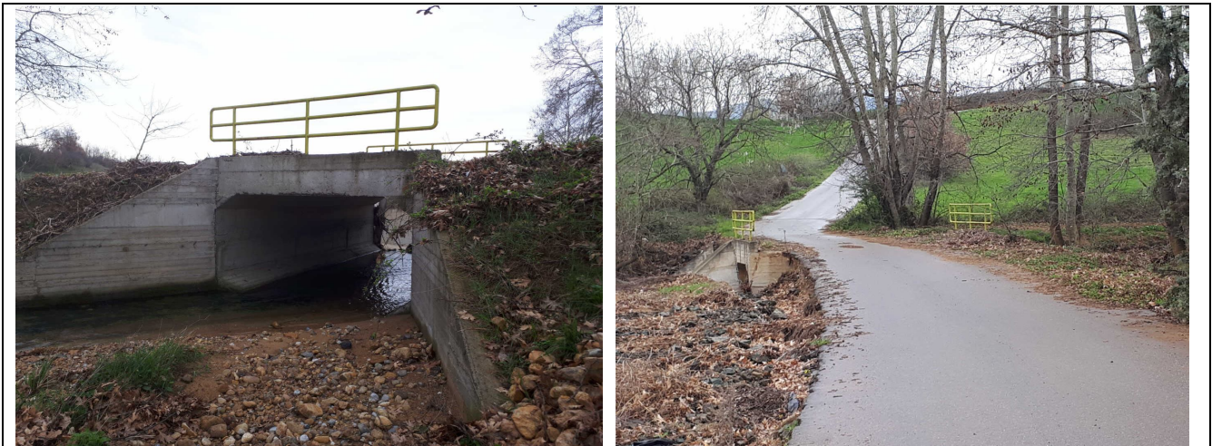
ΦΩΤΟΓΡΑΦΙΕΣ 4,5: Λήψεις από τα κατάντη και επί της οδού. Δεν διακρίνεται κανένα ίχνος υπερκέρσεως του τεχνικού από το νερό, ούτε κάποια εμφανής φθορά στην κατασκευή.
