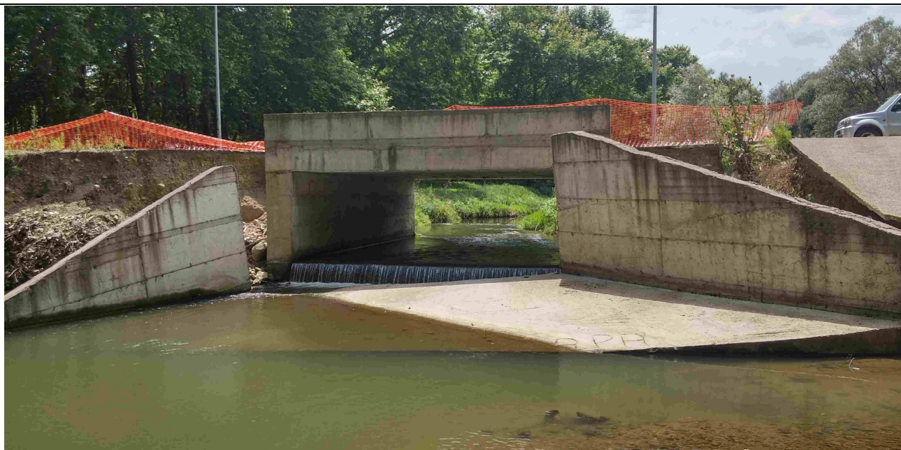
ΦΩΤΟΓΡΑΦΙΑ 3: Κατάντη όψη του τεχνικού. Διακρίνεται η διάβρωση της οδού εκατέρωθεν του τεχνικού και η παράσυρση των πτερυγότοιχων. Στα δεξιά της φωτογραφίας εμφανίζεται και η φθορά στην τσιμεντένια επένδυση, καθώς και η απουσία οπλισμού σε αυτήν.
