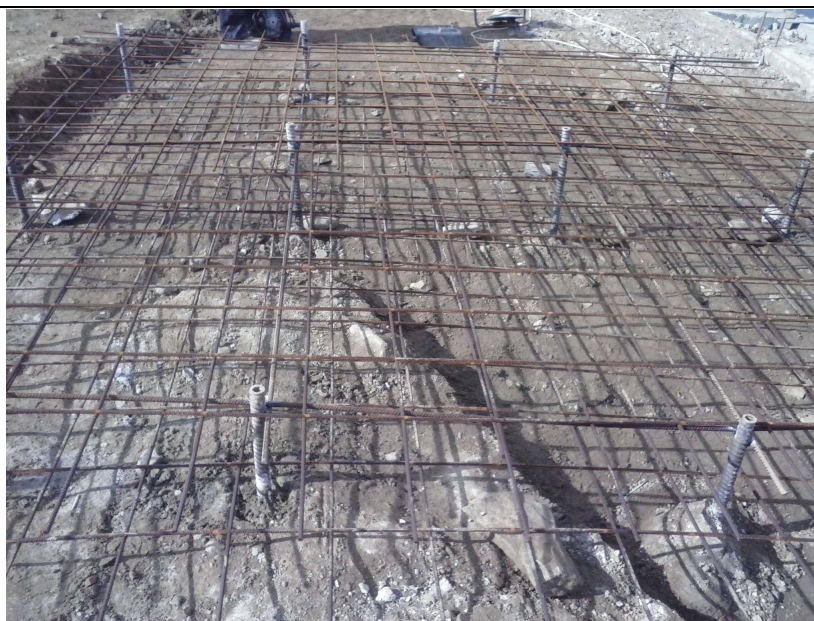
ΦΩΤΟΓΡΑΦΙΑ 11: Προετοιμασία σκυροδέτησης αγκυρωμένης πλάκας με τη χρήση αυτοδιατρήοντων αγκυρίων τύπου TITAN
