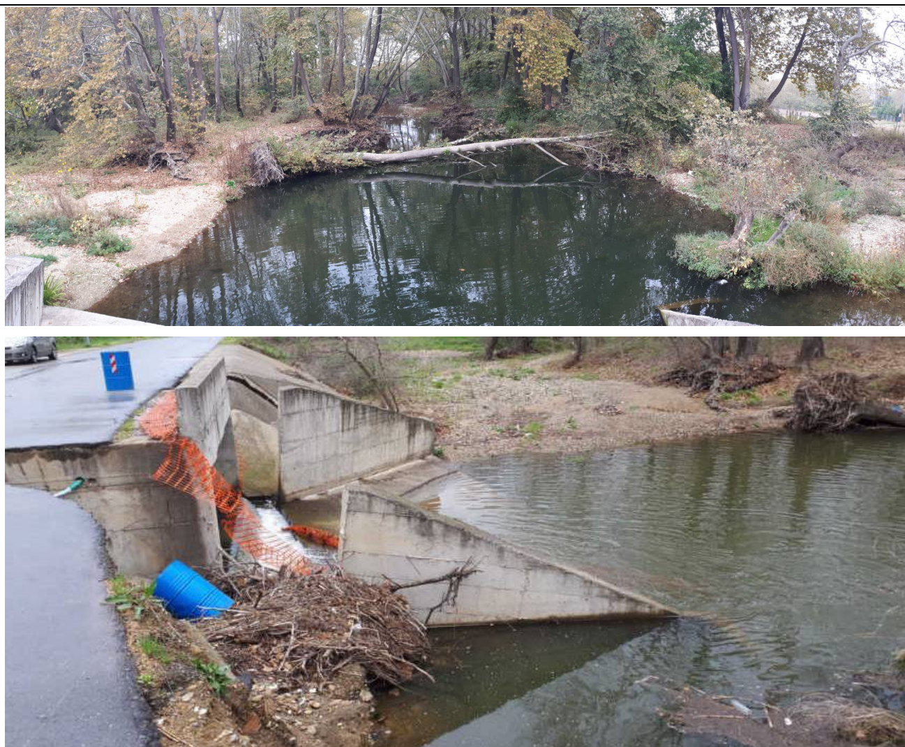
ΦΩΤΟΓΡΑΦΙΕΣ 12-13: Η κοίτη του ρέματος κατάντη του τεχνικού. Είναι σαφής η υποσκαφή που έχει επέλθει.
