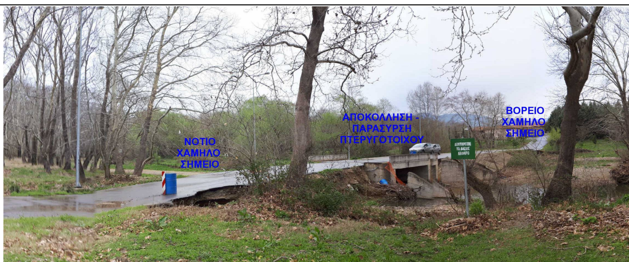
ΦΩΤΟΓΡΑΦΙΑ 4: Κατάντη όψη του τεχνικού. Διακρίνονται τα δύο χαμηλά μηκοτομικά σημεία της οδού στα οποία προκλήθηκε διάβρωση της οδού, καθώς και η αποκόλληση του πτερυγότοιχου.
